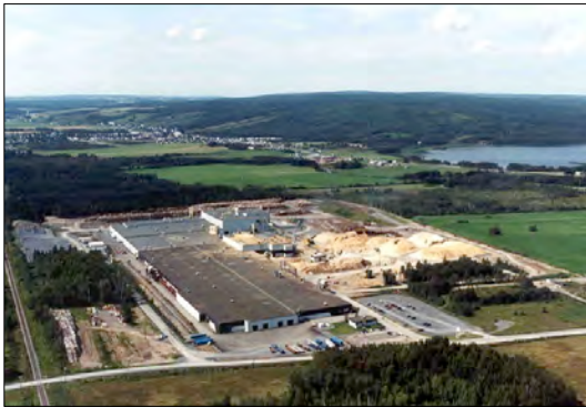
Usine Panval Uniboard à Sayabec
